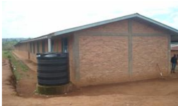
Collecte des eaux pluviales à l'école Primaire de Nyarubenga
