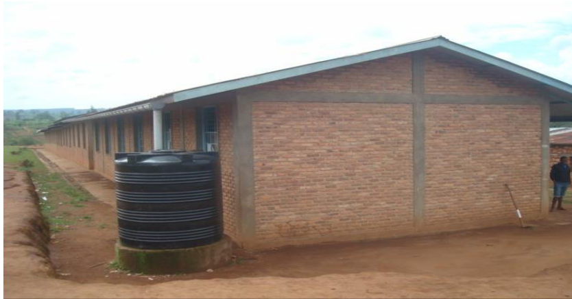
Cette photo de l'école primaire de Nyarubenga est l'illustration de quelques initiatives de collecte des eaux pluviales en vue de faire face aux effets des changements climatiques
