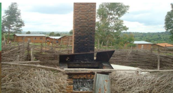
Ce seul incinérateur du CDS Nyarusange est complètement hors usage
