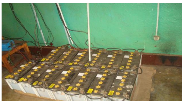
Ces batteries qui jadis servaient de seule source d'énergie pour le CDC Nyarusange est complètement en panne
